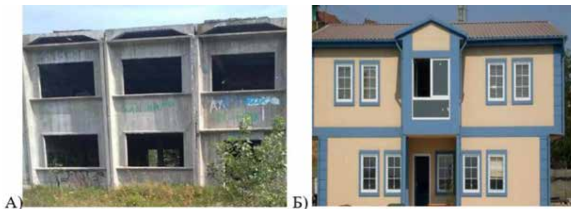
Рис. 2. Промисловий склад: А) До реконструкції; Б) Після реконструкції
